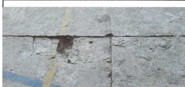
Foto 6: sustitución Losa de Patio
