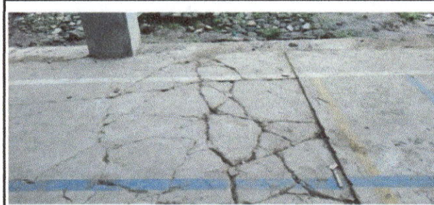
foto 5: Sustitución losa de patio
